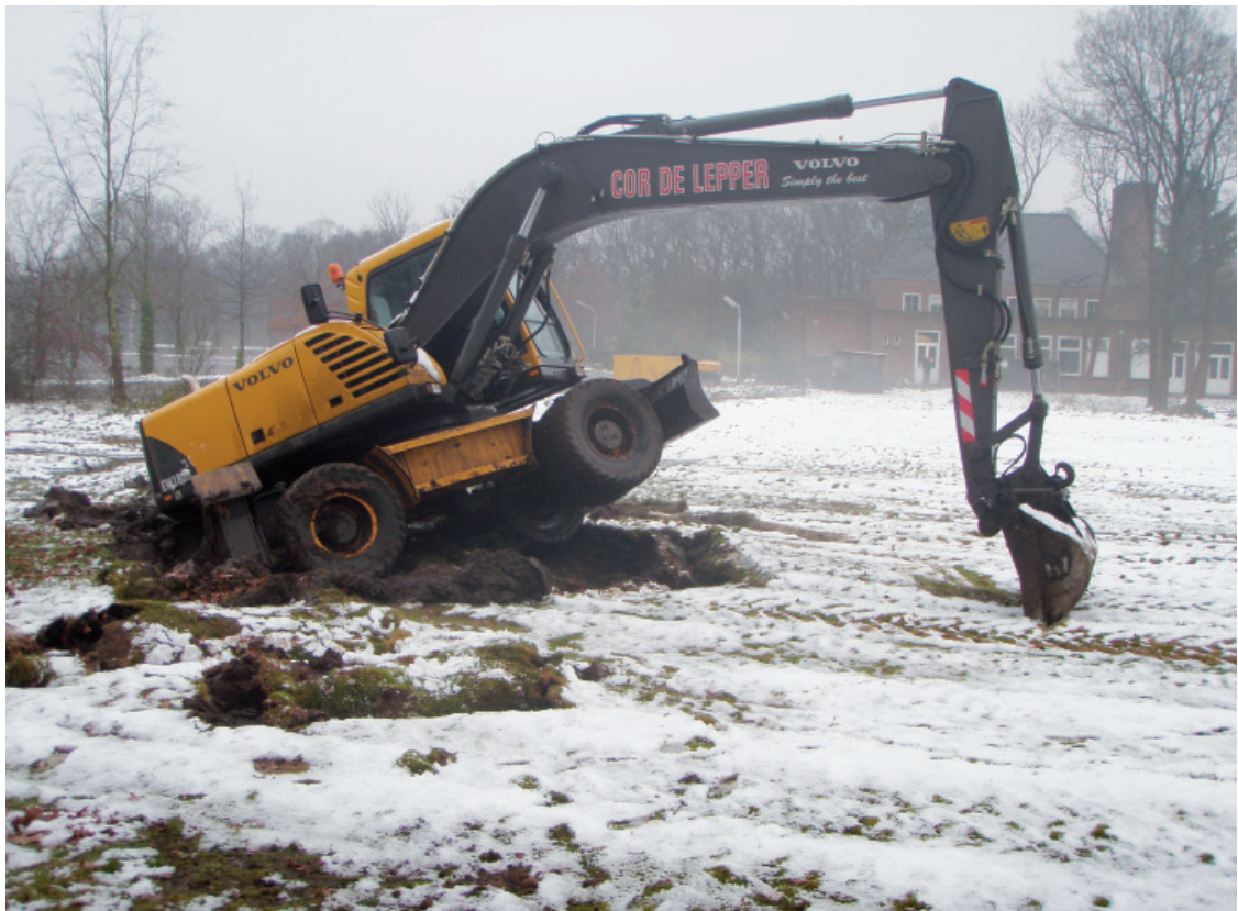
Afb. 5.1 De aanleg van de sleuven verliep niet altijd even vlekkeloos.
